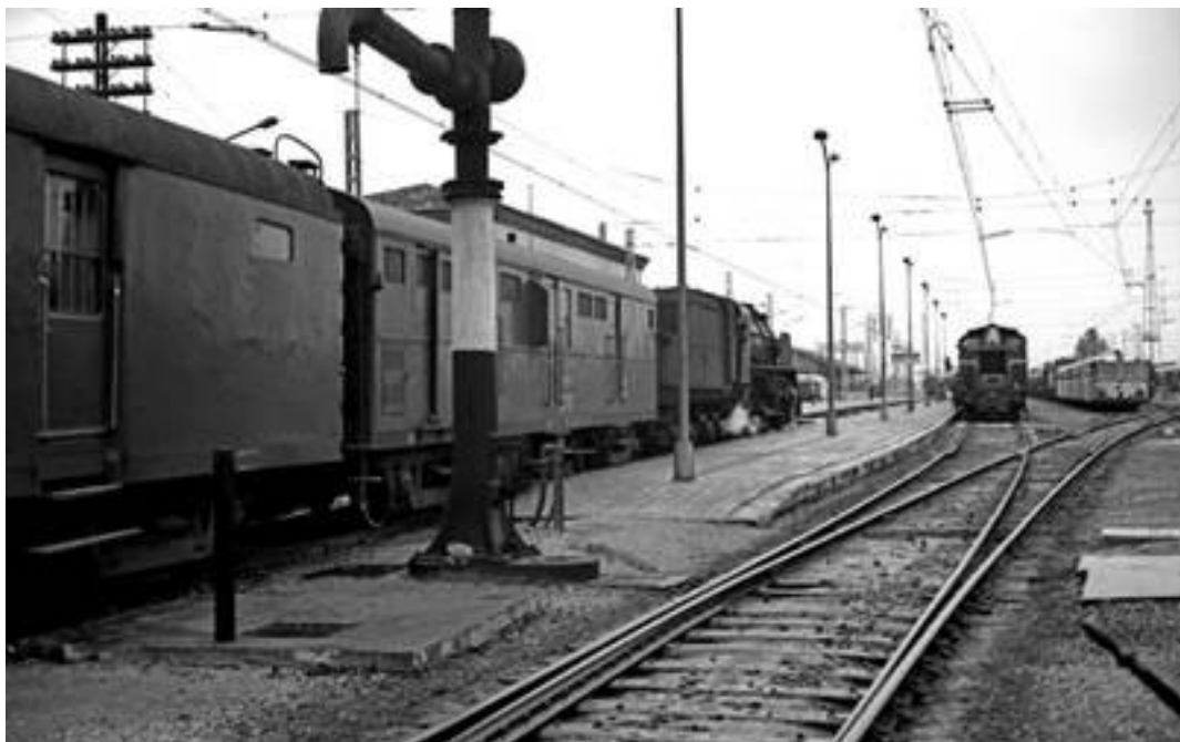
Toma de agua. Foto: Jaume Roca
