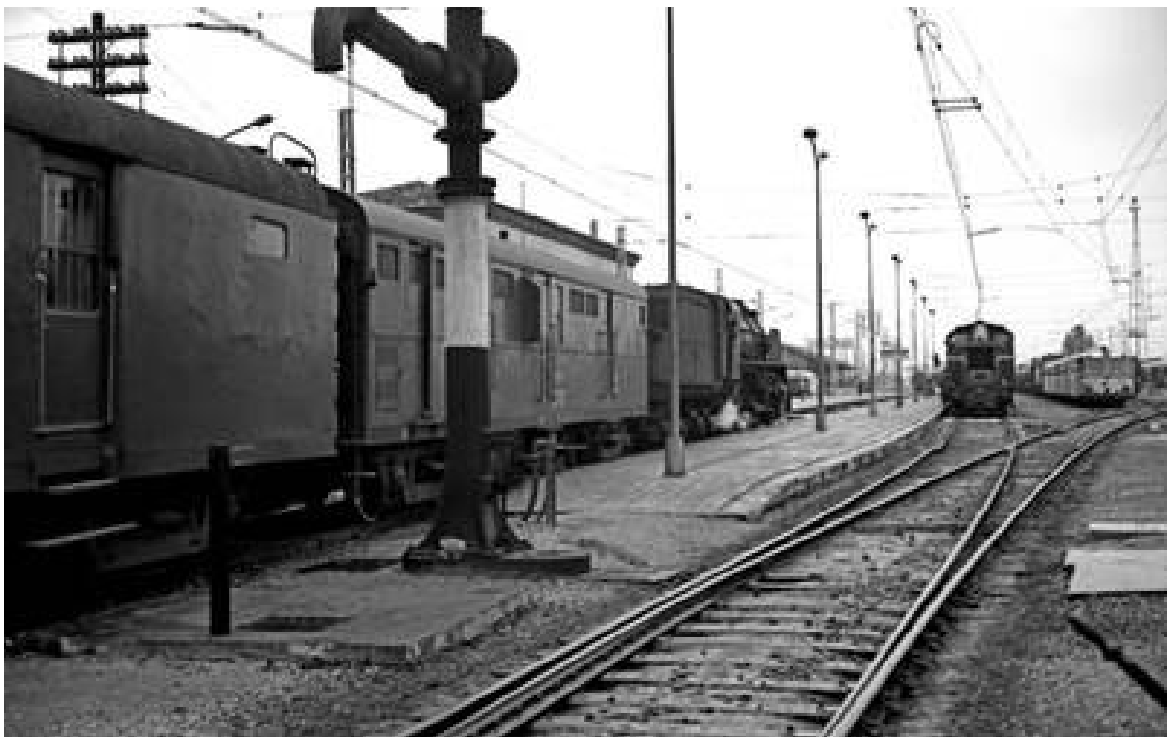
Toma de agua. Foto: Jaume Roca
