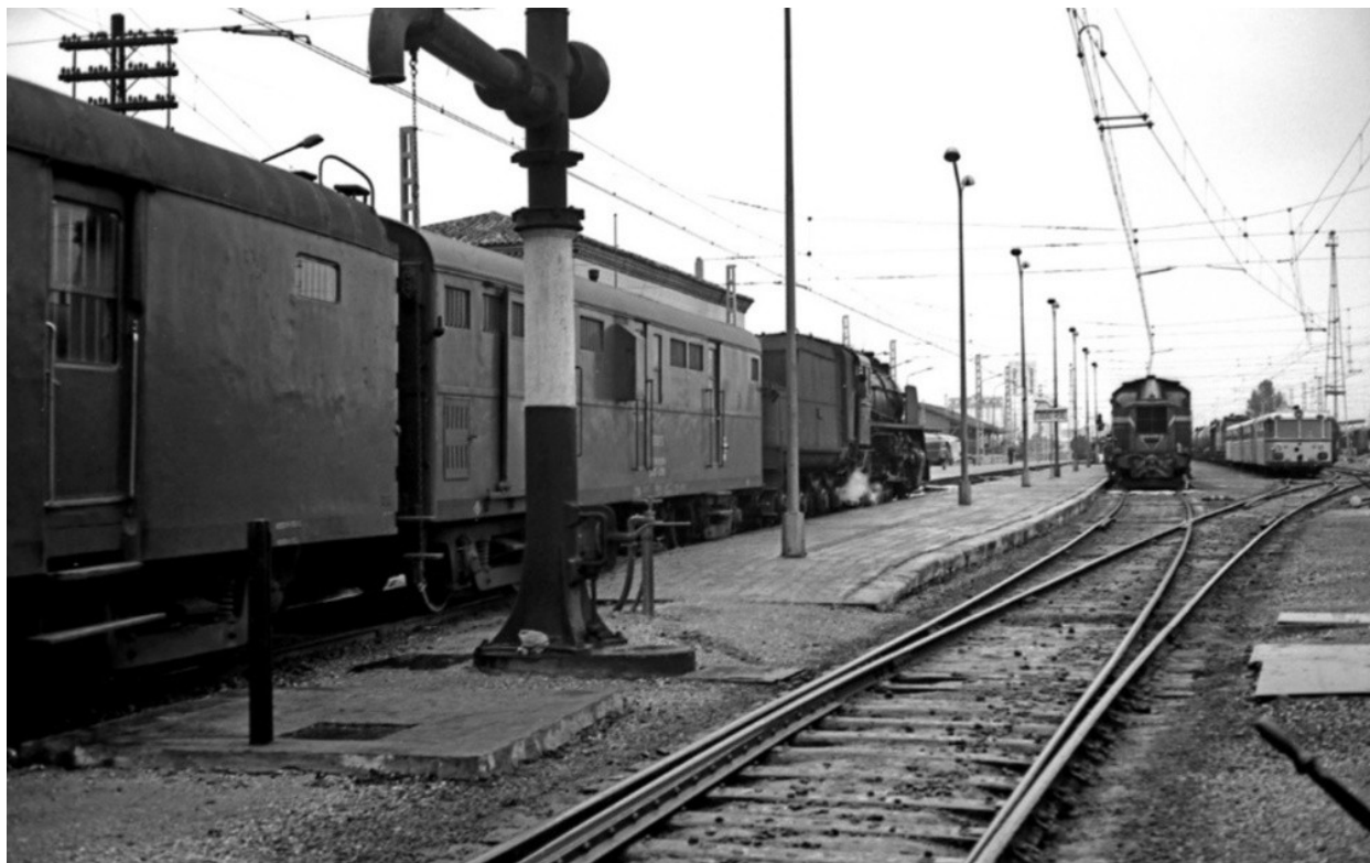
Toma de agua - Foto: Jaume Roca
